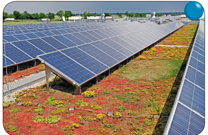
Solaranlage auf einem Gründach.
